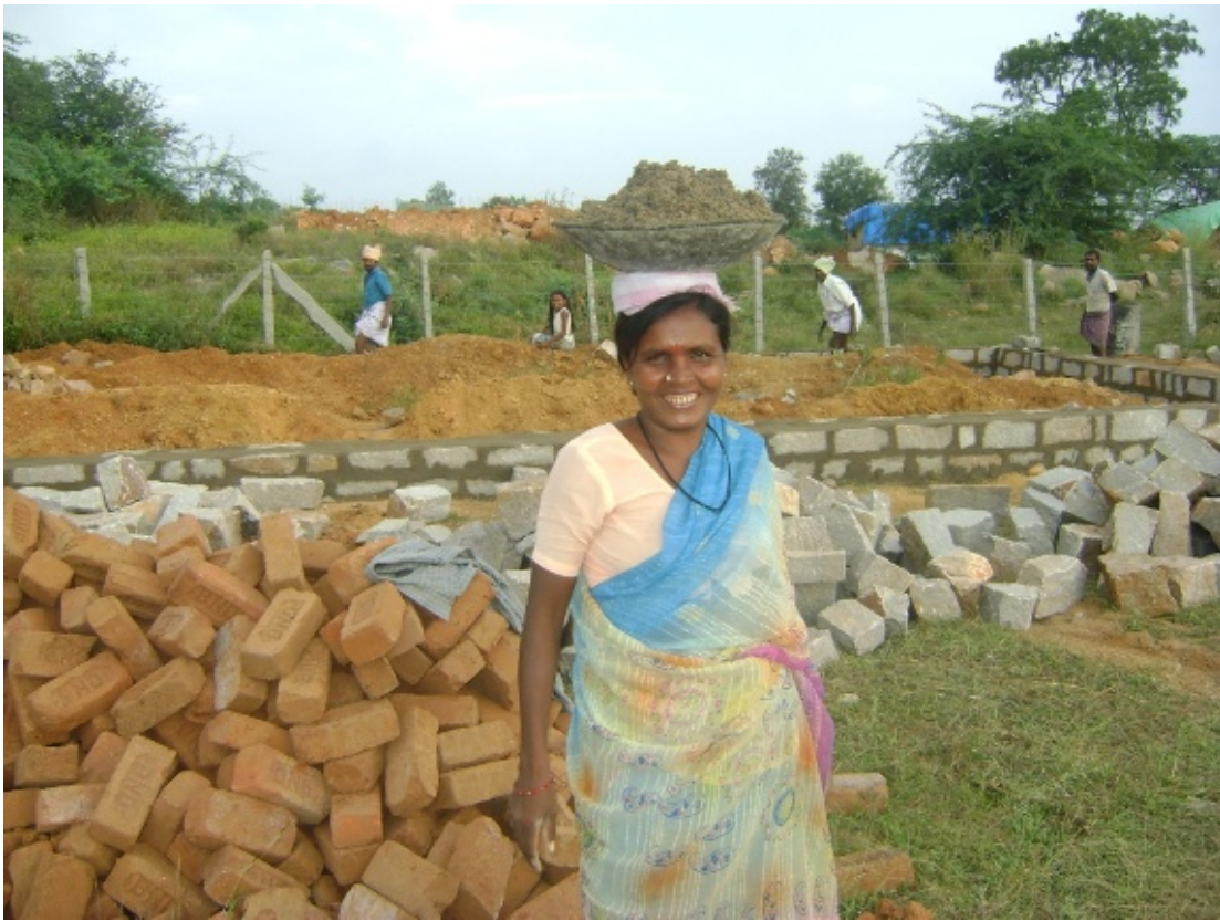
Bauarbeiterin vor dem Fundament für die Lagerhalle
