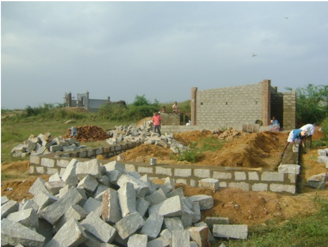
Eingangstor (hinten links) und Fundament der Lagerhalle vor dem Vielzweckhaus im Bau
